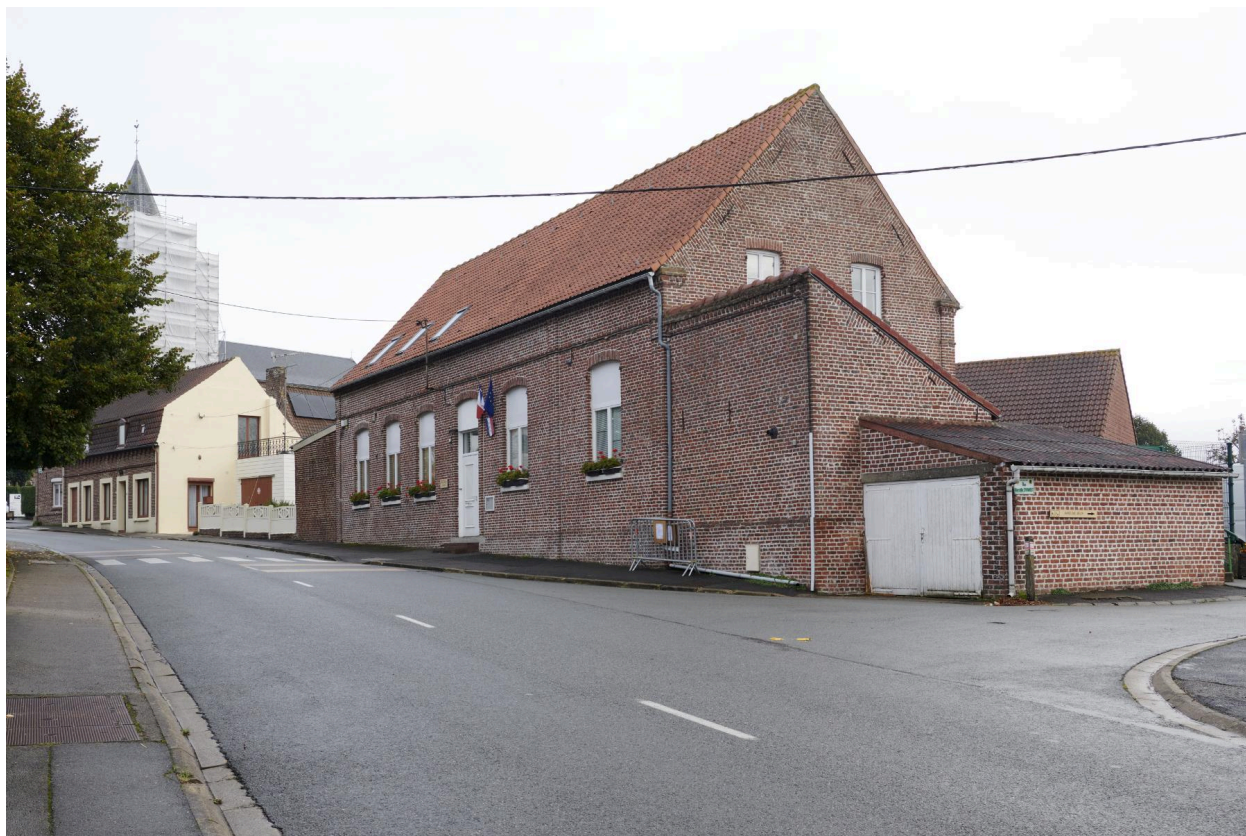
Vue générale depuis le sud.
