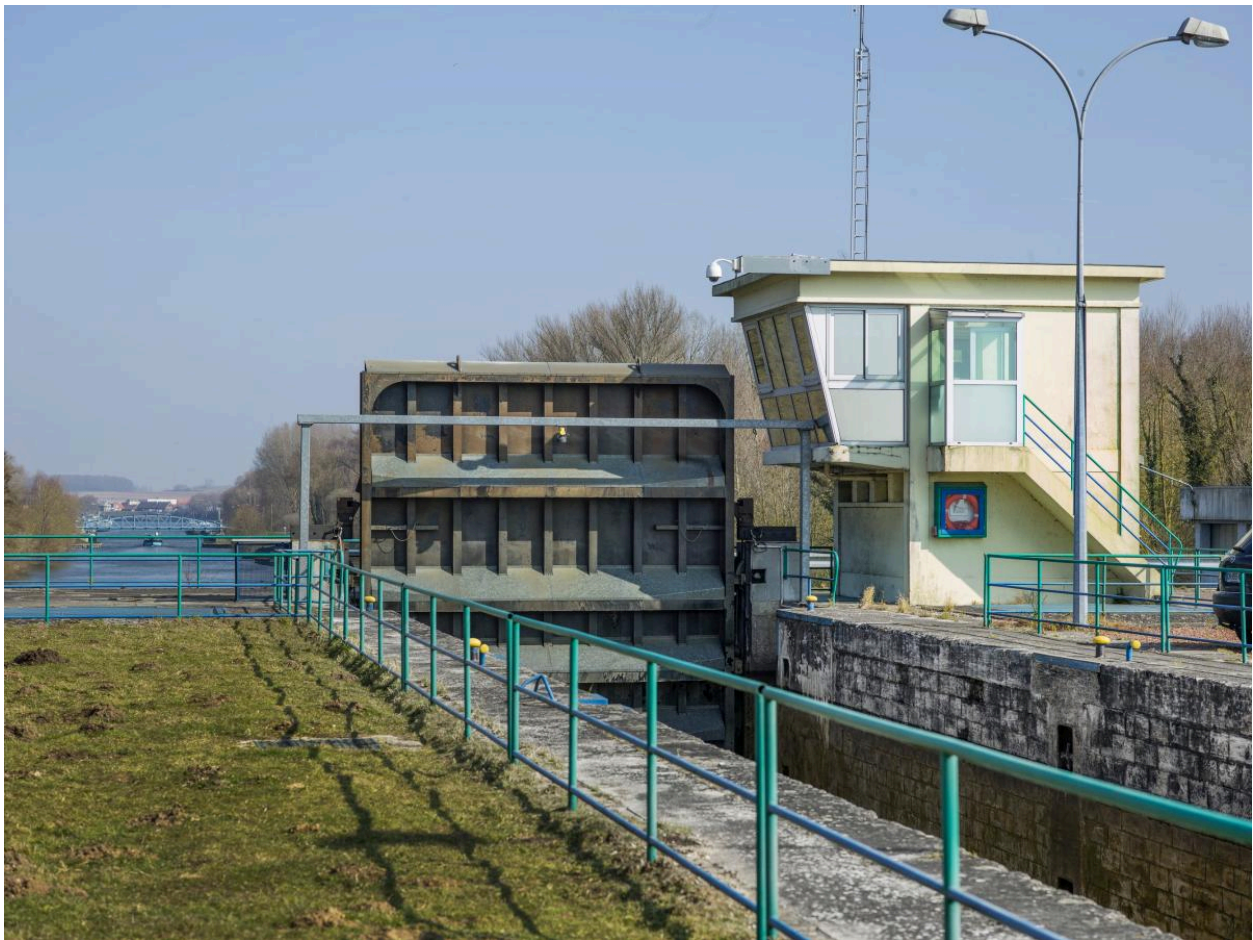
Poste de commande et porte levante.
