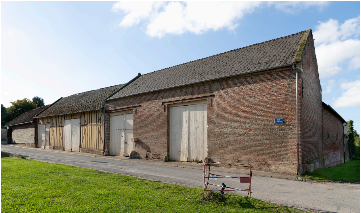
Deux anciennes granges sur la rue, n°2 de la rue de Breteuil, vue depuis le nord-est.
