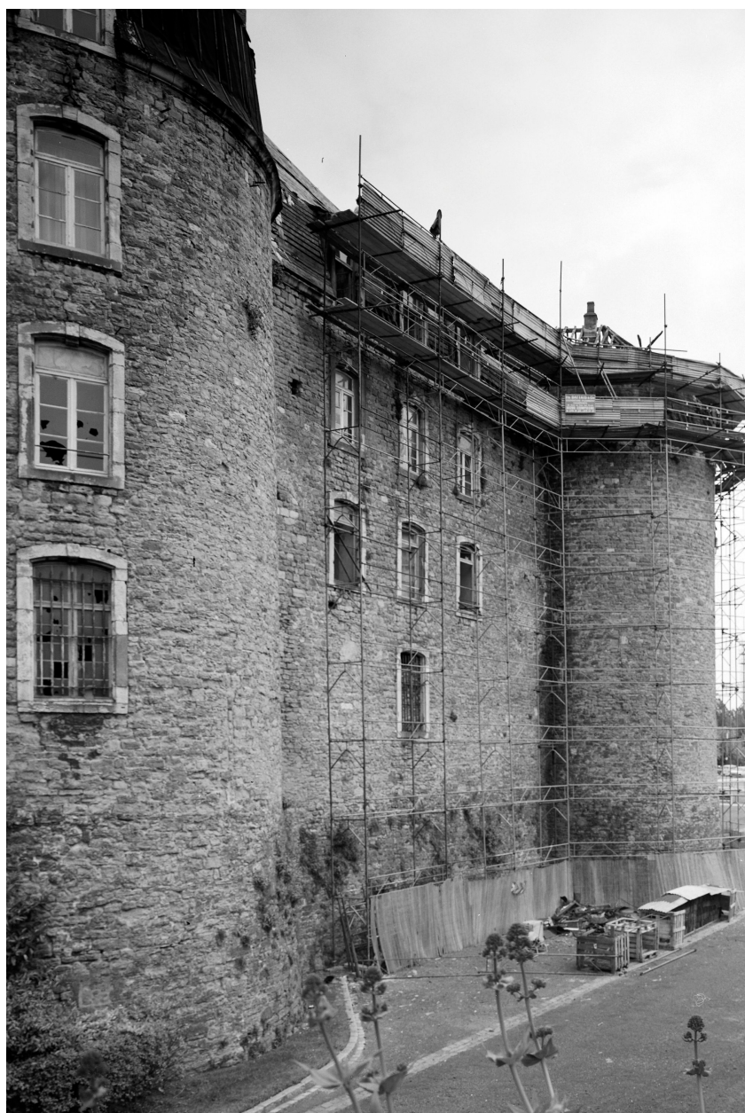
Façade sud-ouest en cours de restauration.
