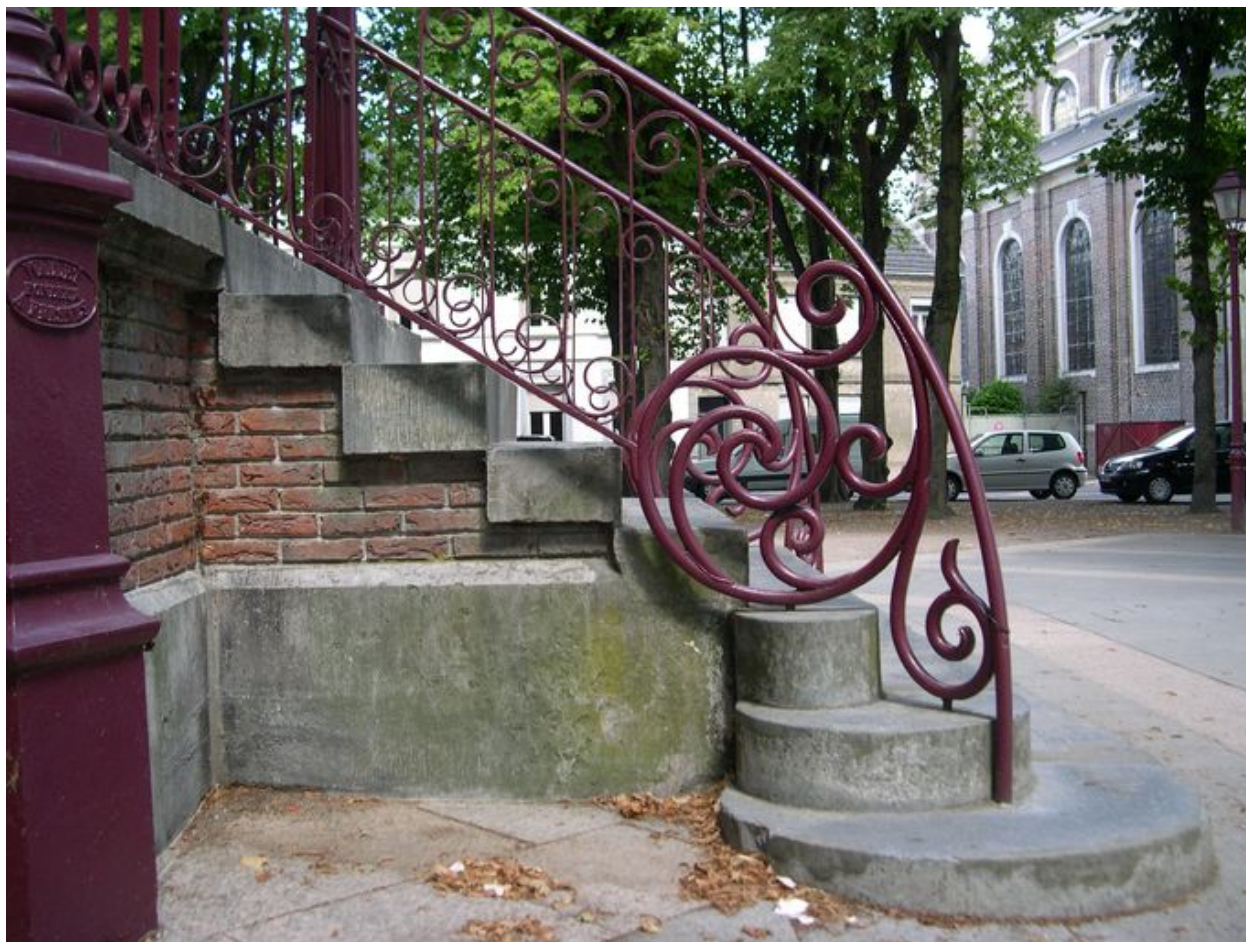
Détail : escalier d'accès et son garde-corps en ferronnerie.
