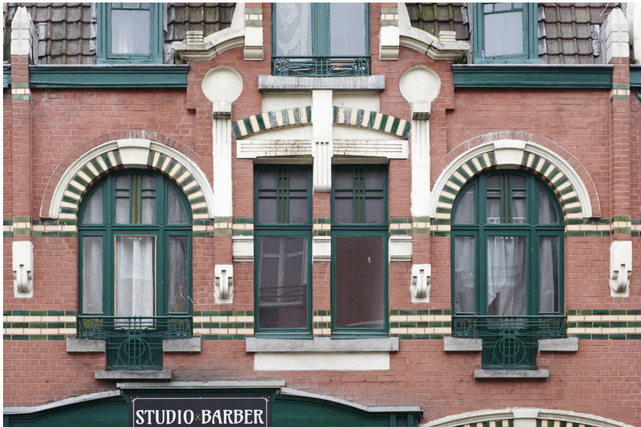
Détail de l'encadrement des fenêtres et des baies.
