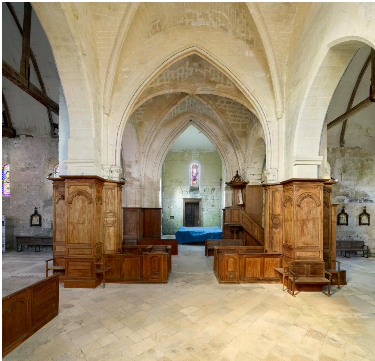
Vue générale du lambris de la croisée du transept.
