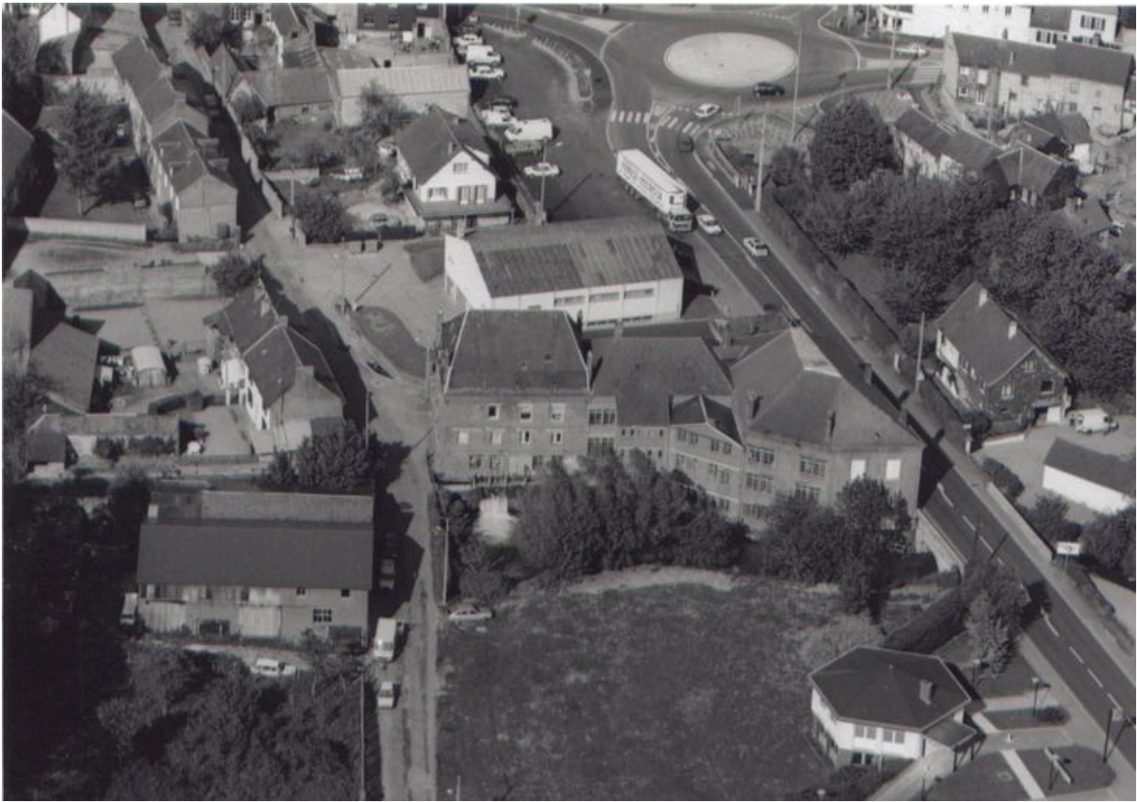
Vue aérienne de l'usine en 1994.
