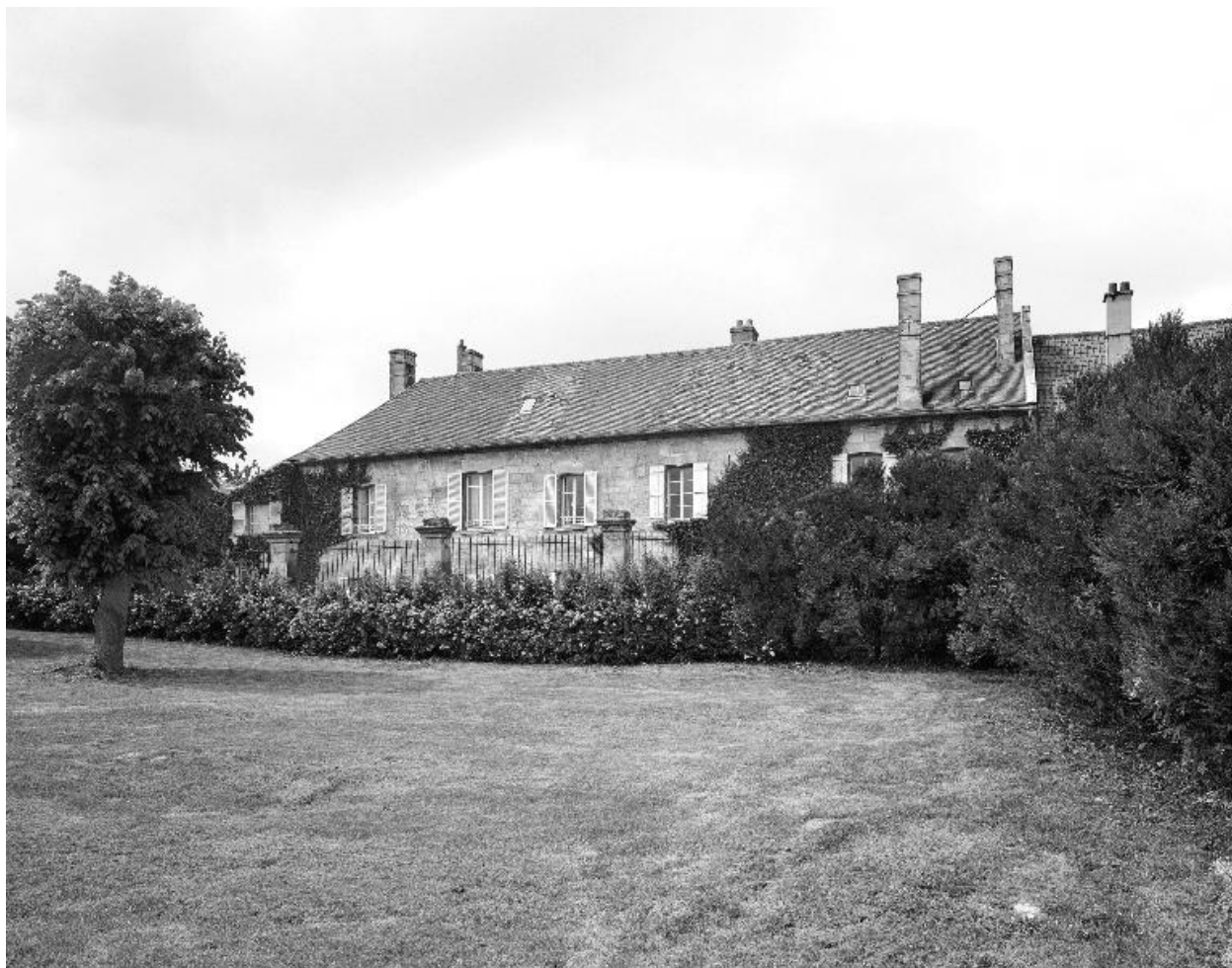
Logis : vue de l'élévation extérieure sud-est.
