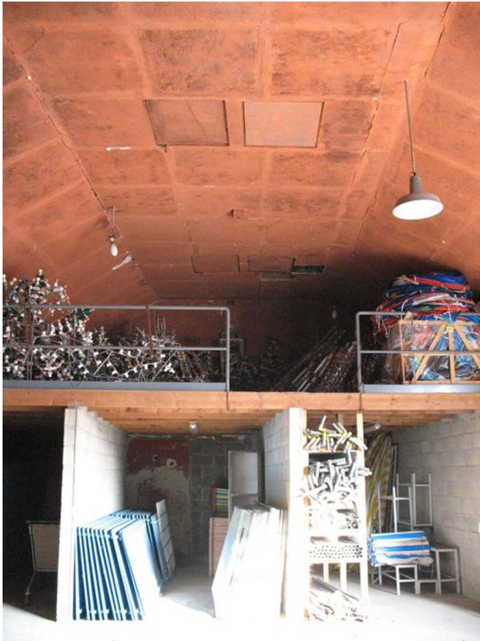
Intérieur de l'ancienne salle de cinéma.
