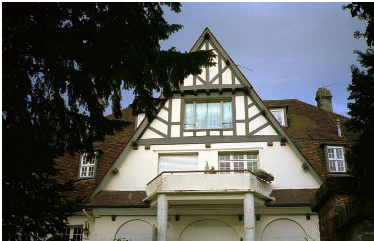
Détail de la façade.
