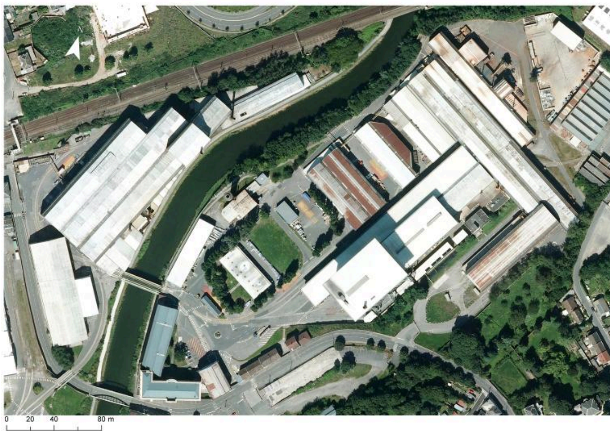
Vue aérienne de l'usine en 2015 (IGN. Photothèque nationale. 2015).
