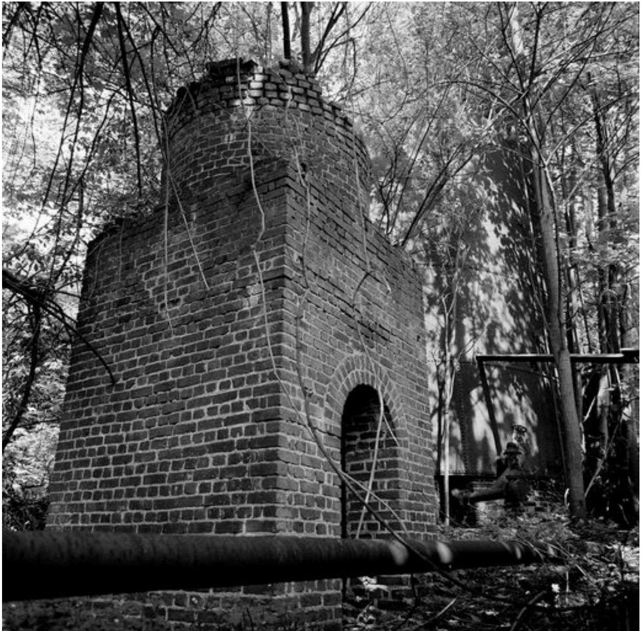
Cheminée d'usine : socle.
