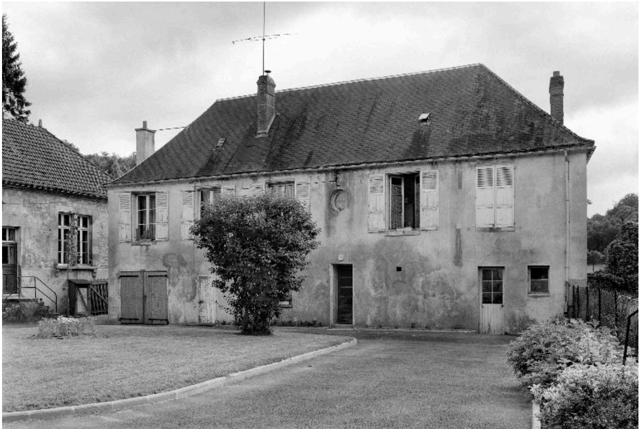
Ancien bâtiment des communs, ayant ensuite servi de logement pour l'instituteur : vue de l'élévation orientale.
