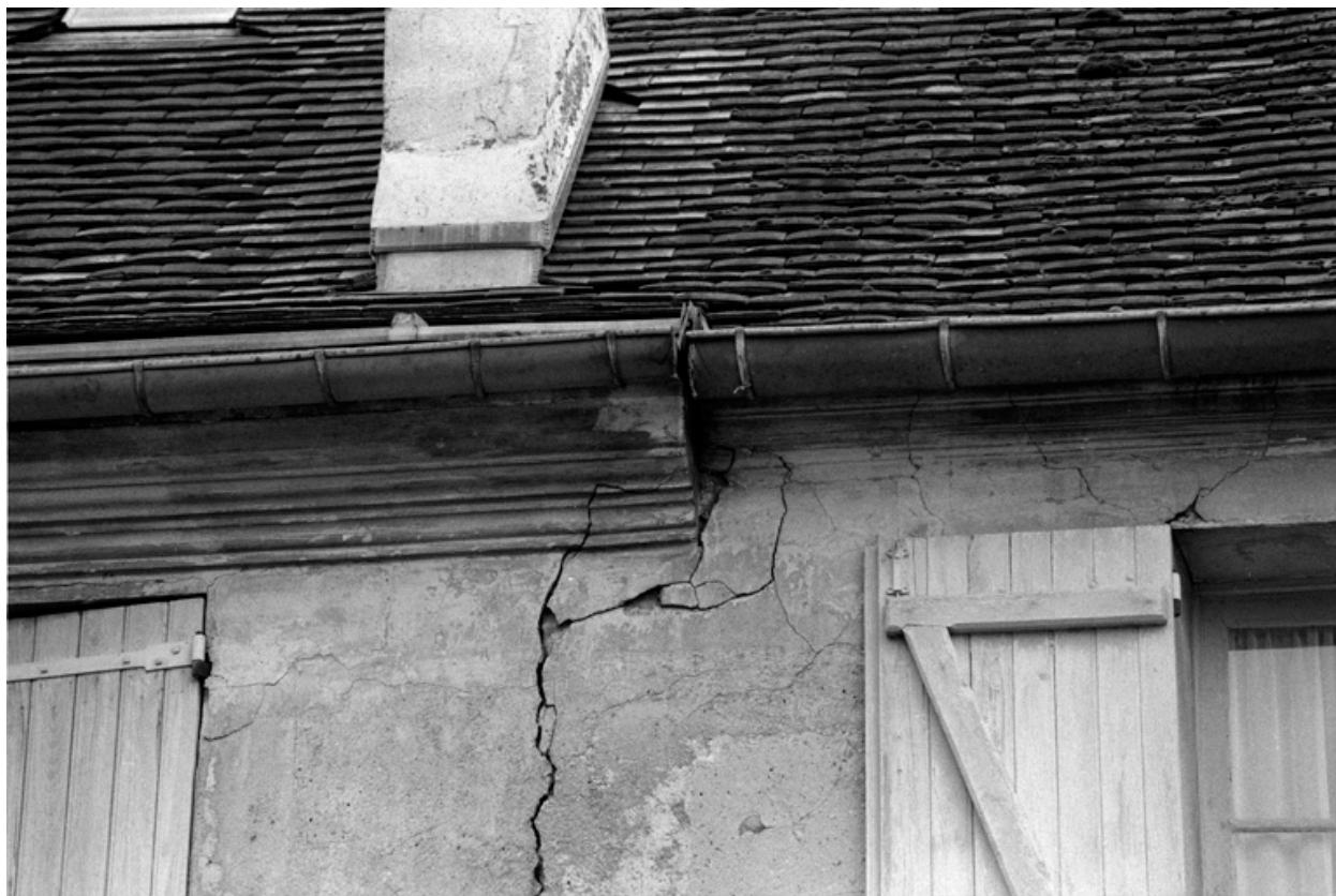
Détail de la corniche de la façade sud et vue des bâtiments conventuels.
