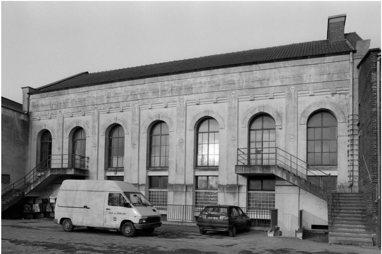
Salle des machines, en 1991 : élévation sud.
