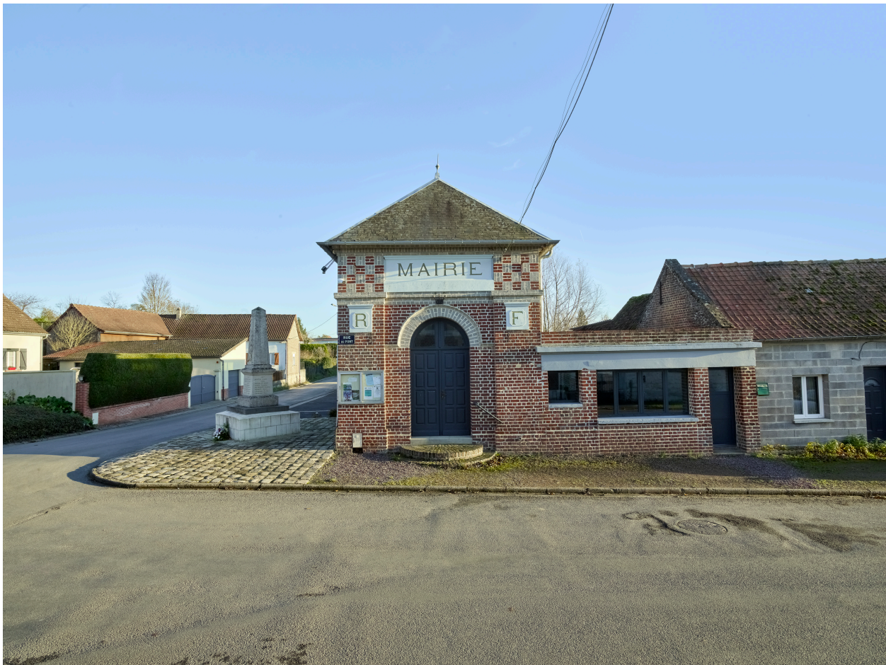
Vue de la mairie, depuis l'ouest.
