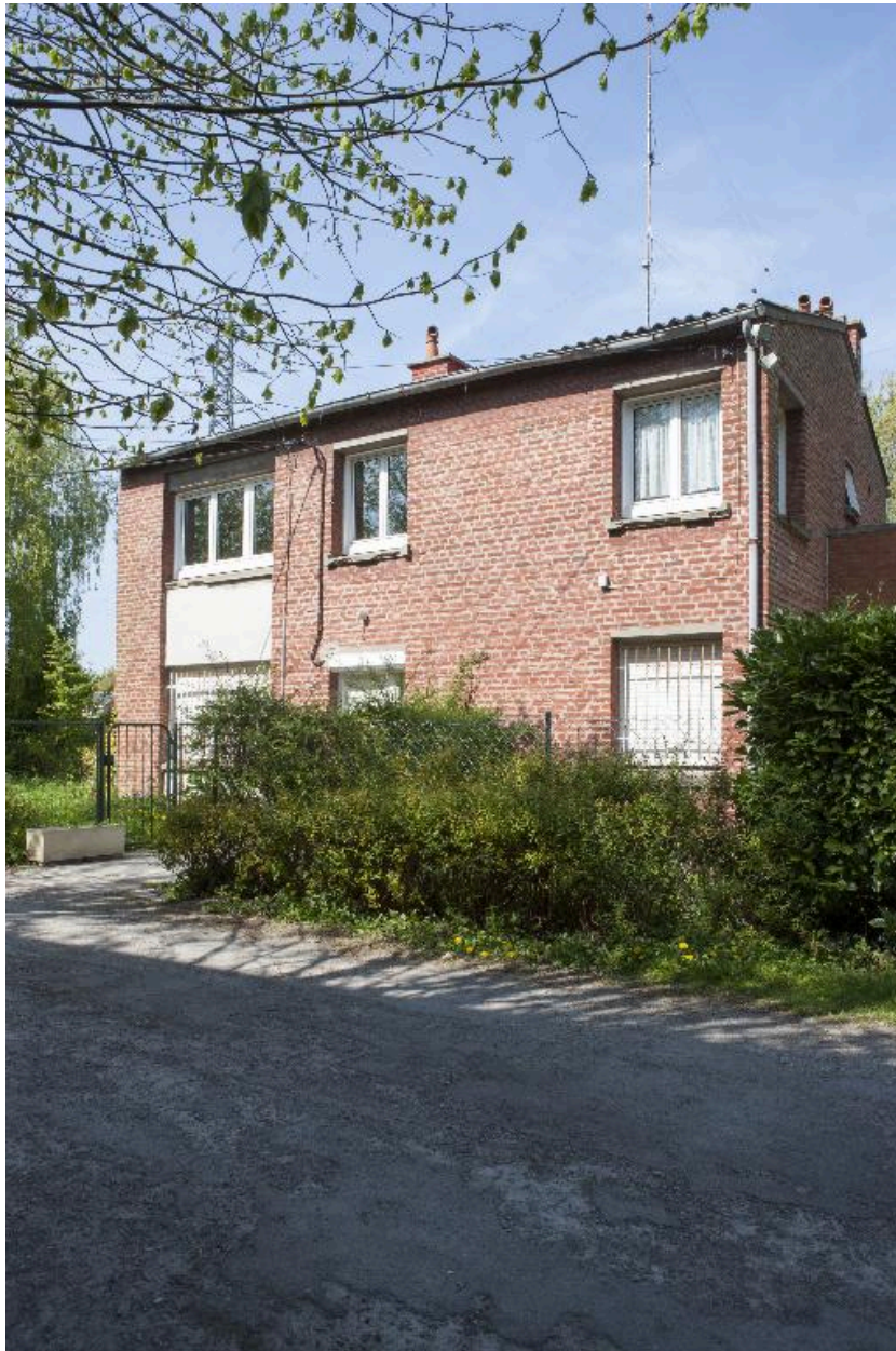
Façade de la maison paroissiale.
