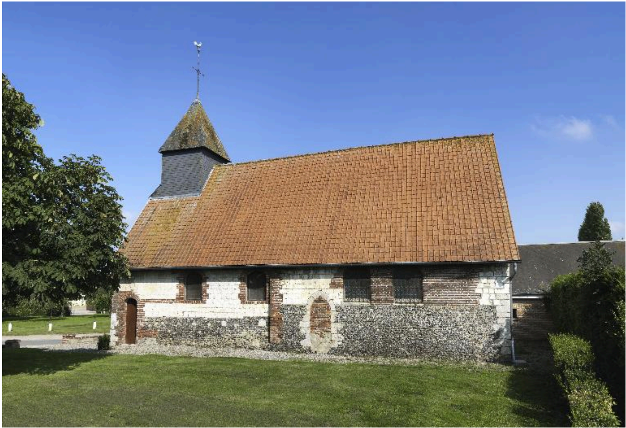
Vue du mur gouttereau sud.
