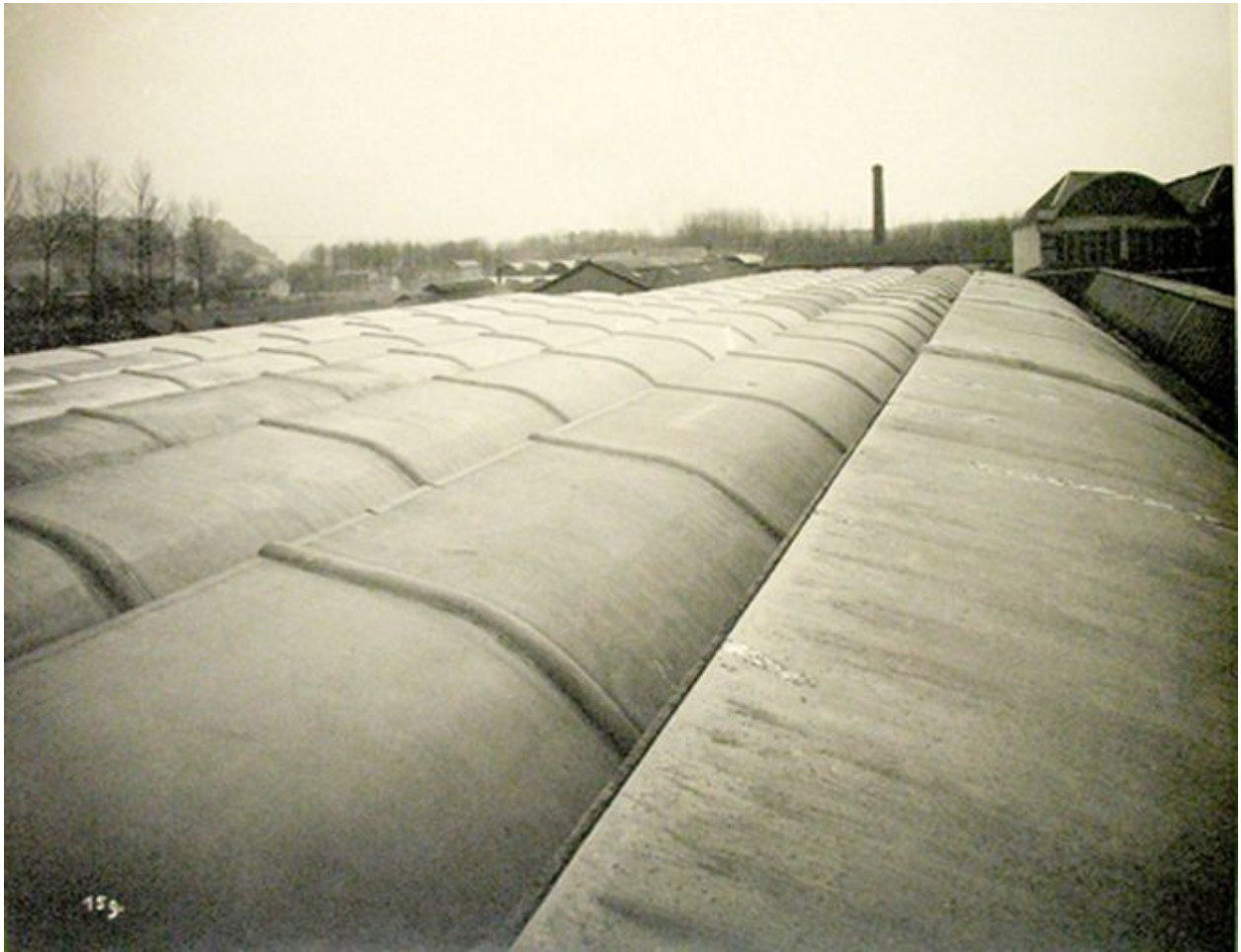
Détail de la couverture en sheds ovoïdes en béton des ateliers, vers 1925 (IFA ; 535 AP 651/7).
