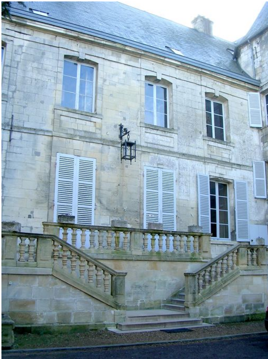
Escalier 17e siècle sur la façade nord.
