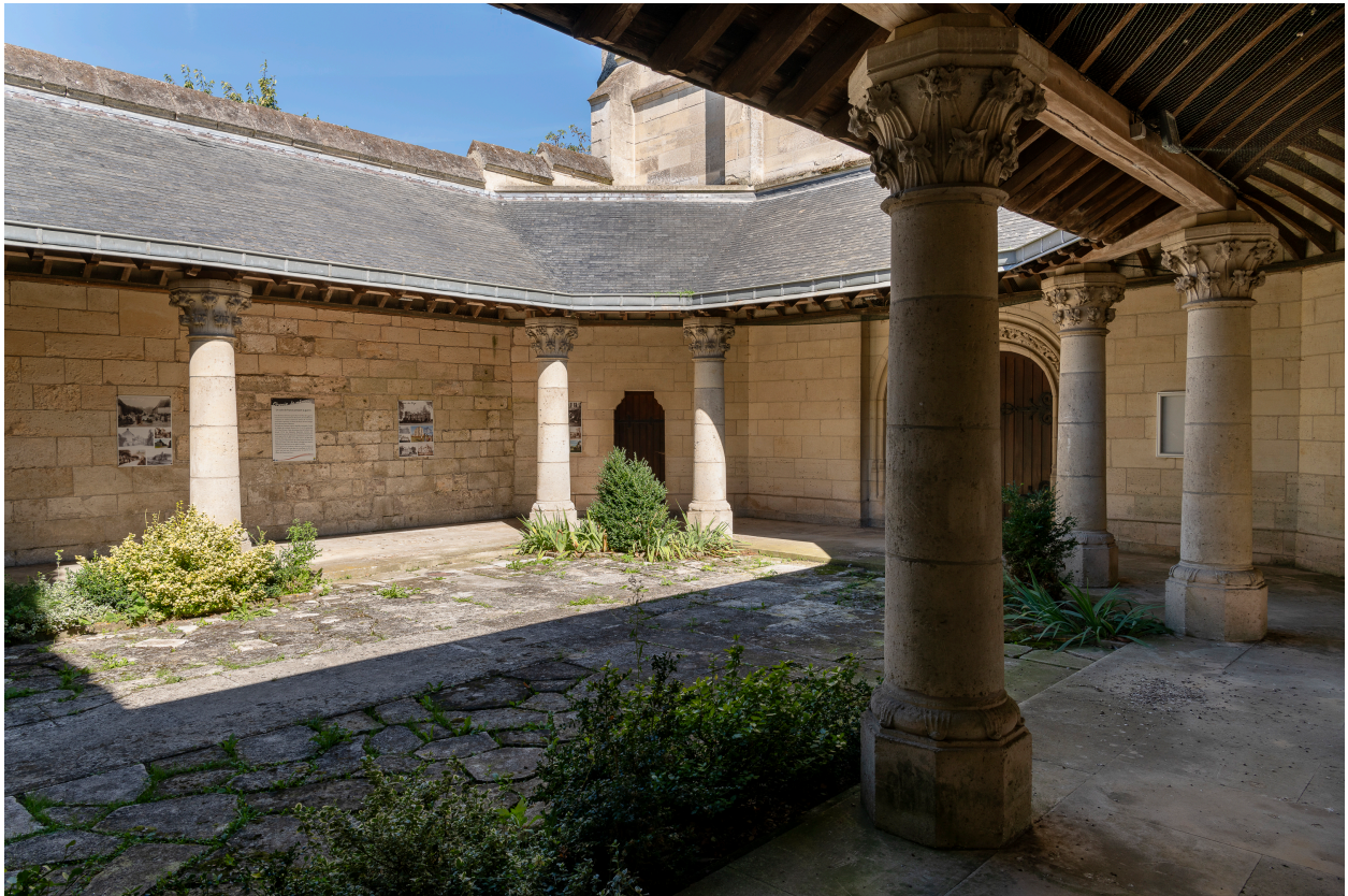
Ancienne nef dite "cloître" : vue de trois quarts depuis la galerie méridionale.
