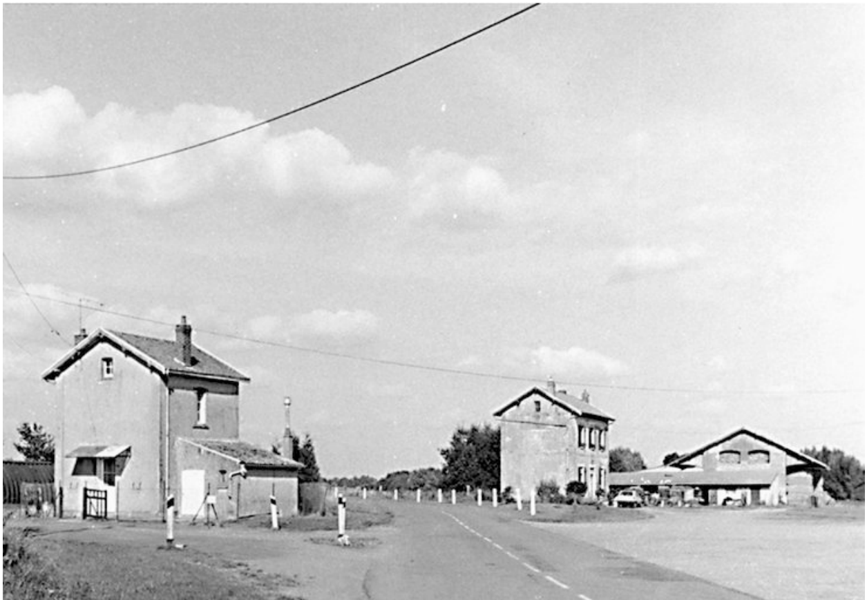
Ancienne gare : vue générale des bâtiments.
