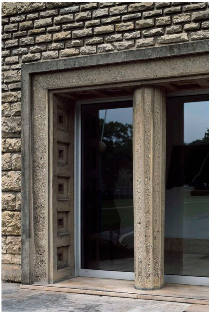
Détail de la façade d'entrée : pilier évasé.
