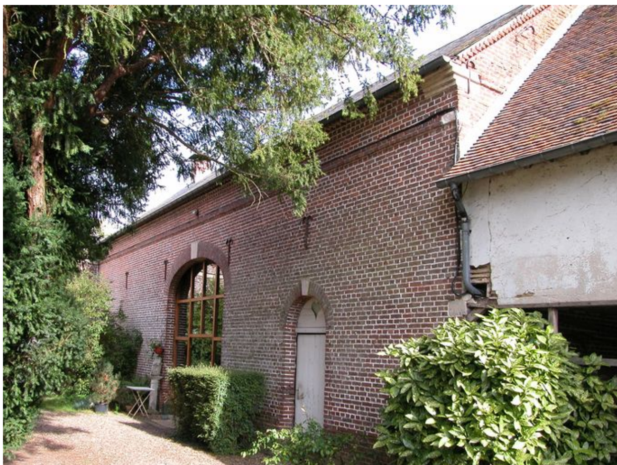
Les granges, façade sur cour.
