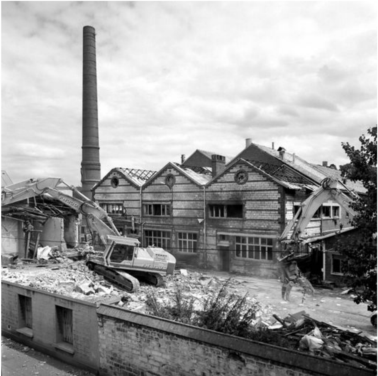
Démolition des bureaux, en 1999.
