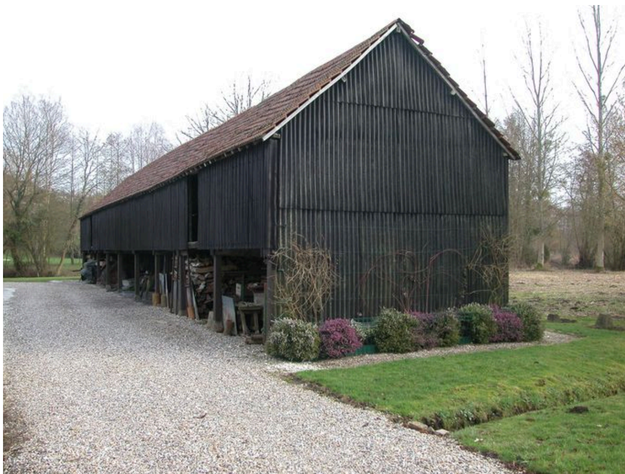
Bâtiment de stockage des bois, vue d'ensemble.
