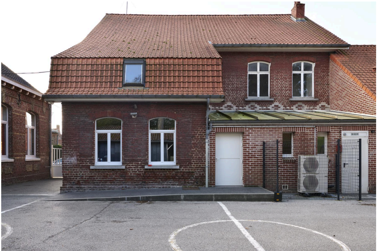
Arrière du bâtiment principal (ouest).
