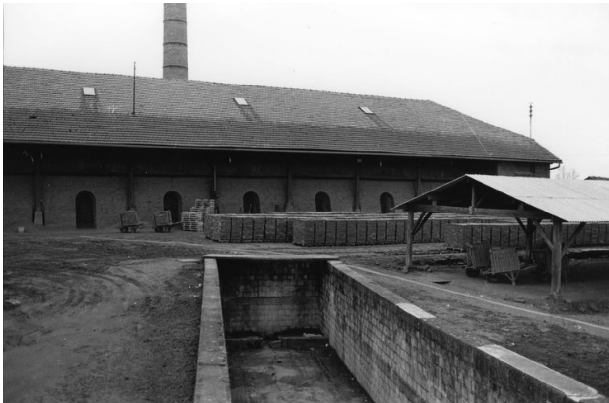
Four et halles de séchage. Au premier plan, fosse de chargement en vrac, utilisée pour les véhicules à chevaux, état en 1989 (AD Oise).
