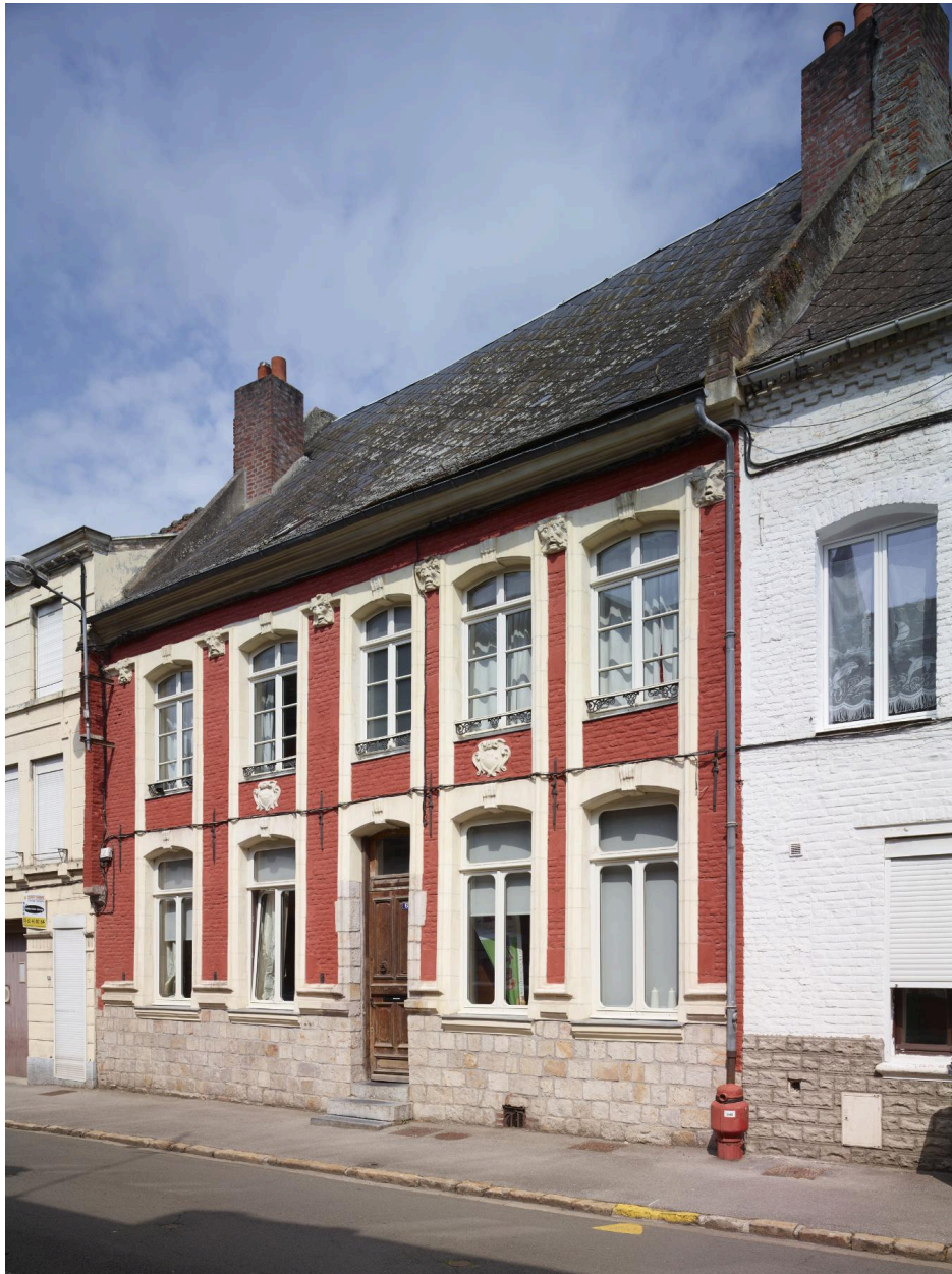
Façade principale, vue orientée ouest/est.
