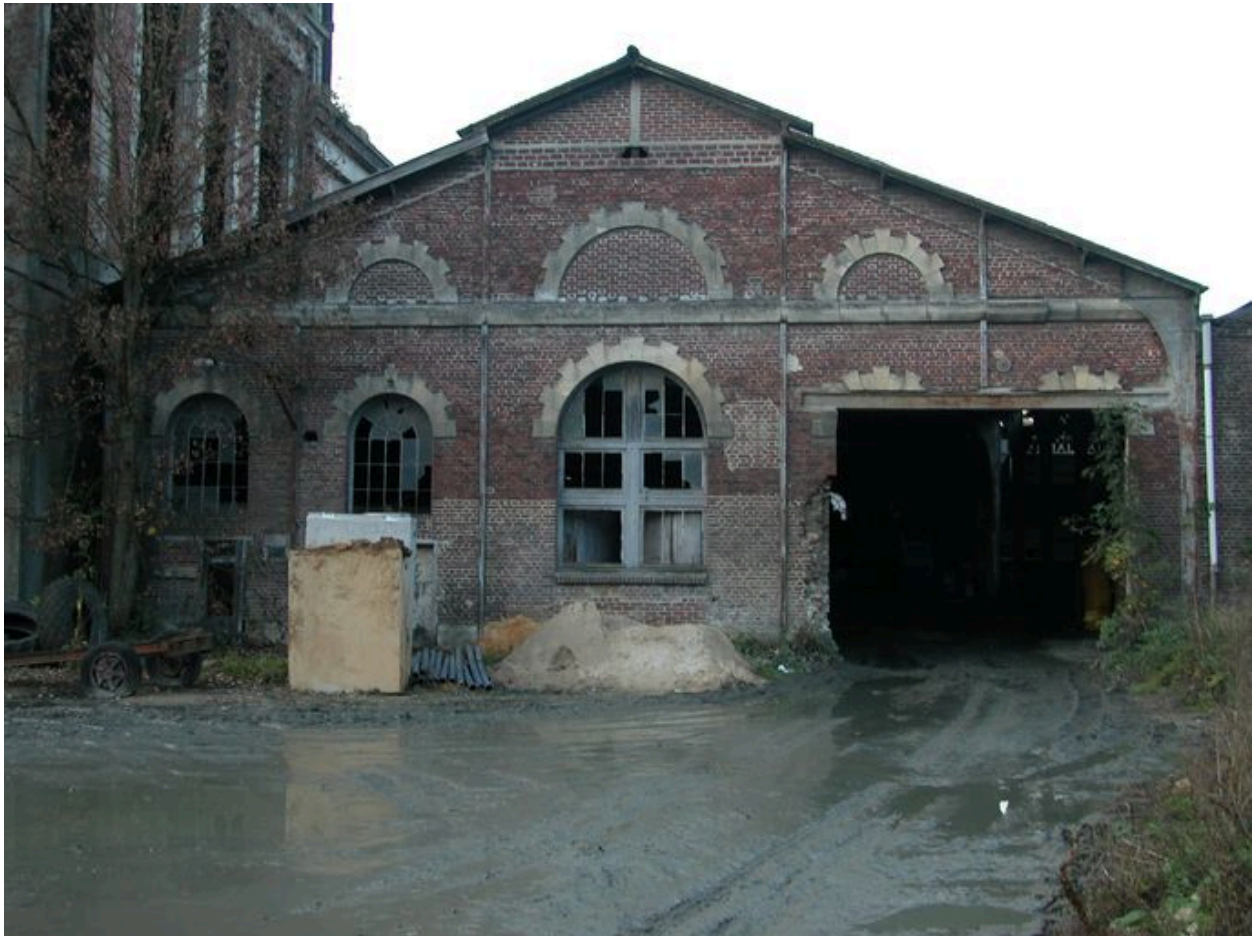
Atelier de teinture des cotons attenant à la chaufferie, façade sud.
