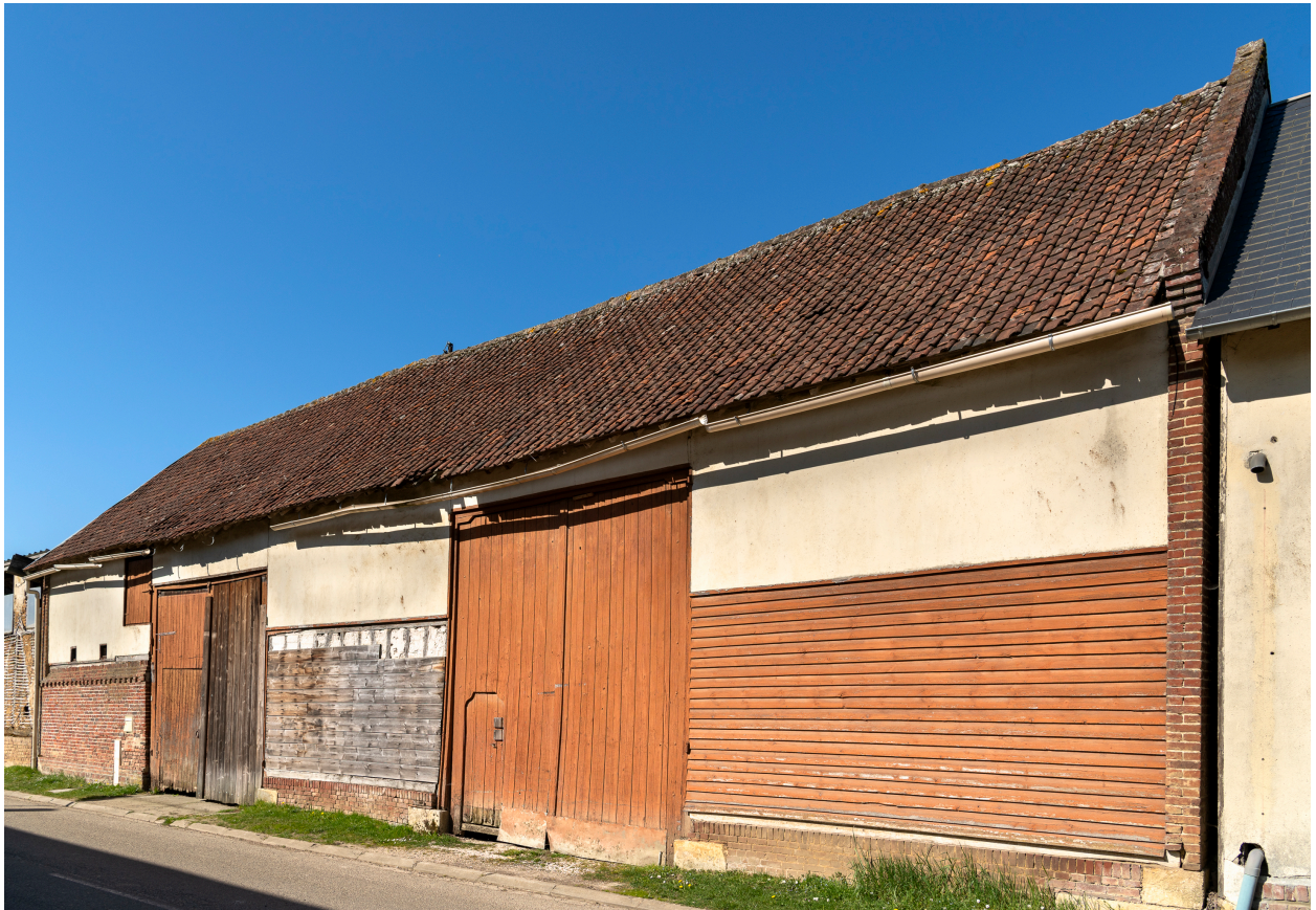
Ancienne grange sur rue avec deux entrées charretières, n°69 de la rue Behaize, vue depuis le sud.
