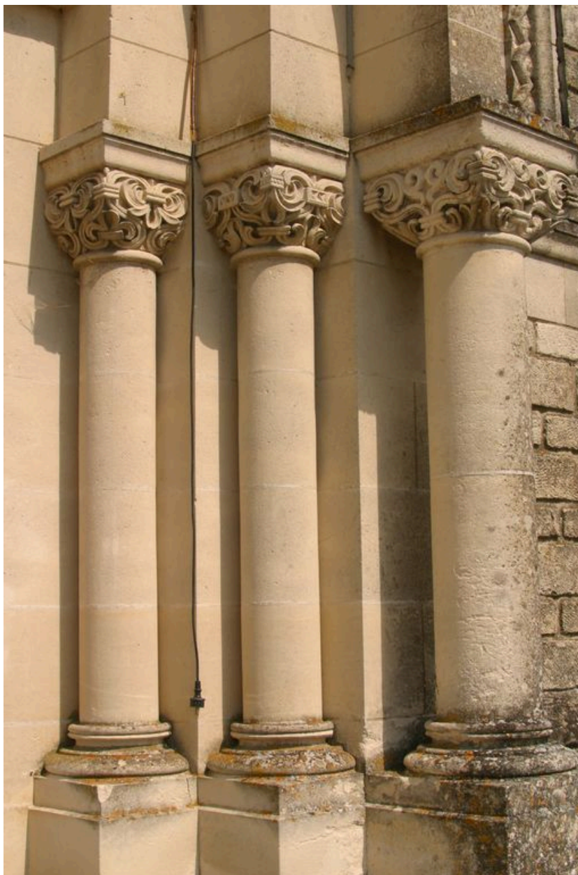
Détail des colonnes du portail.
