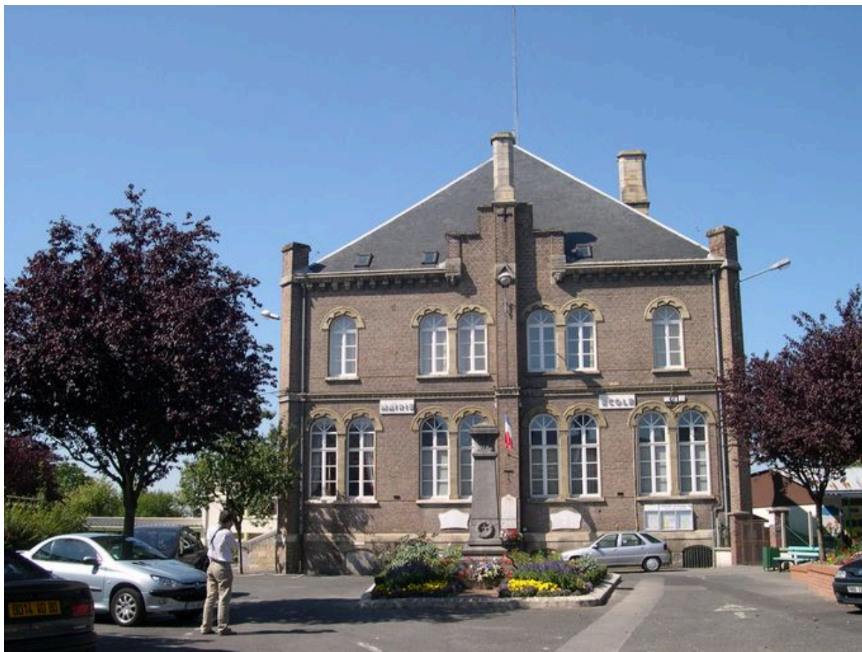
Vue générale, depuis l'est.
