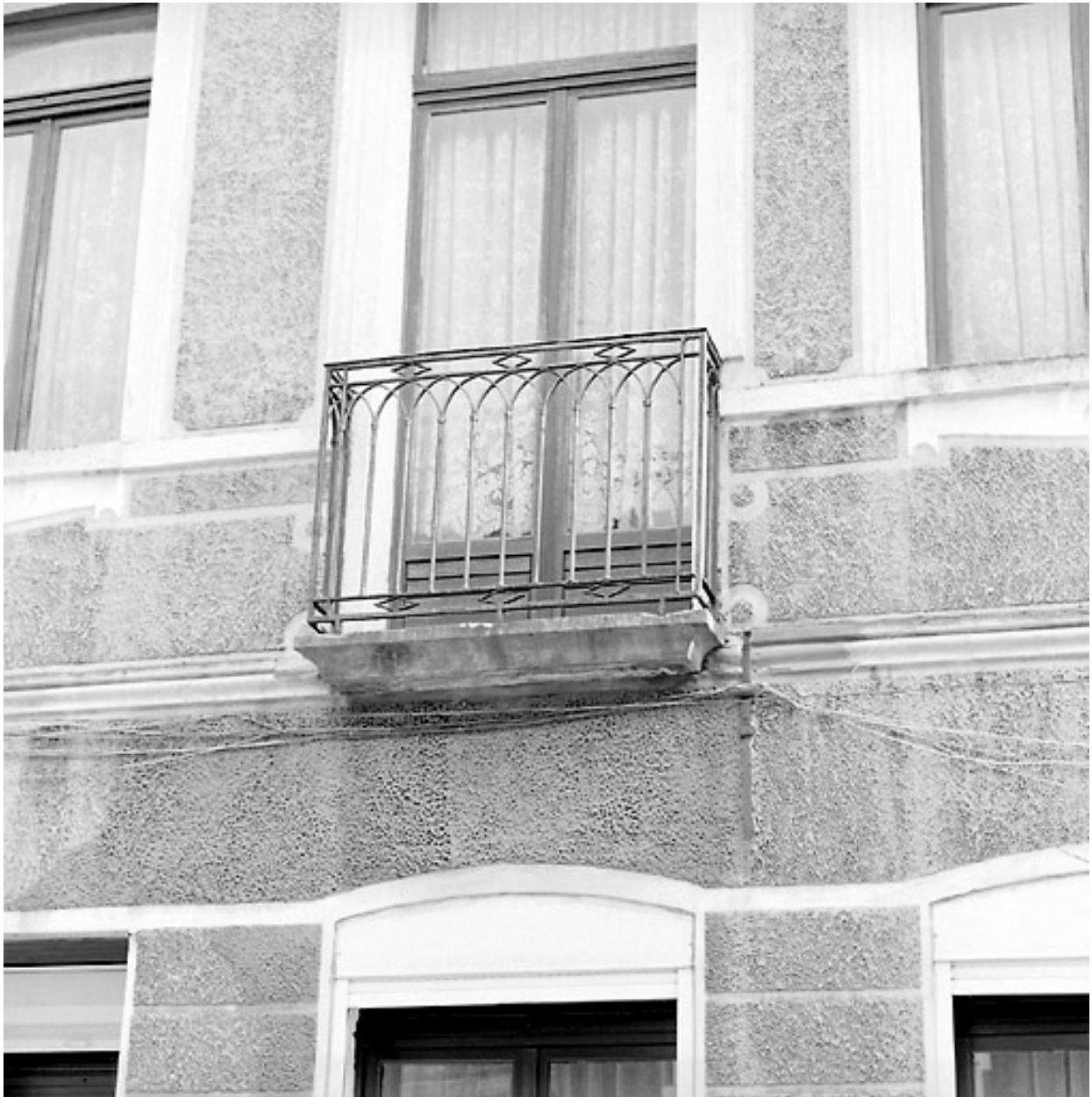
Façade du n° 80, détail : garde-corps du balcon.
