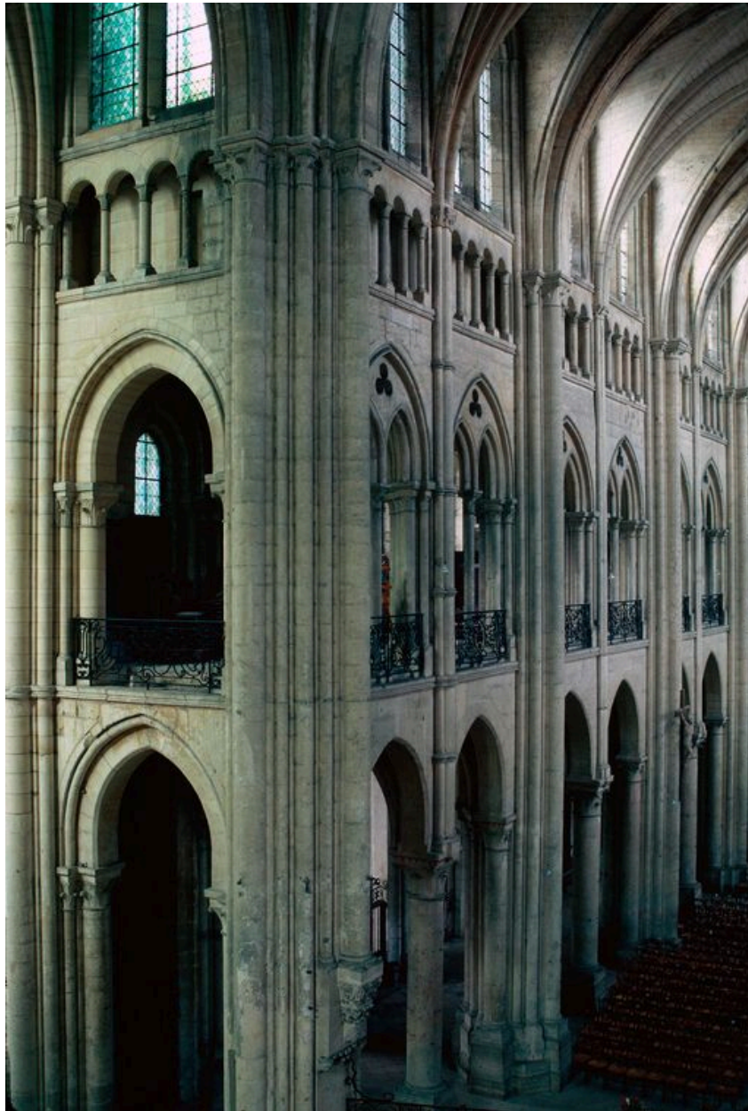
Vue intérieure de la nef et du bras sud du transept.
