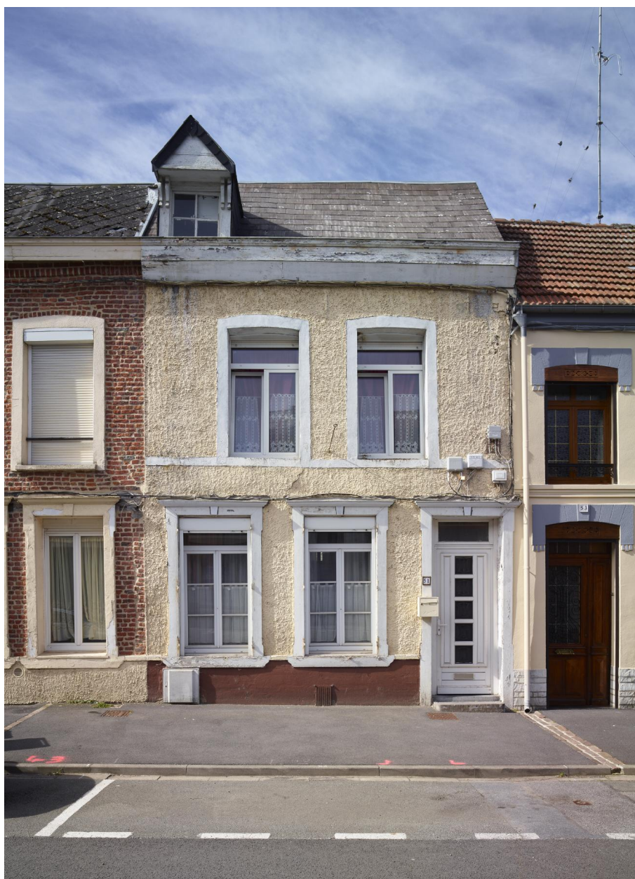
Maison, 51 rue Thiers : façade entièrement enduite en nid d'abeille.
