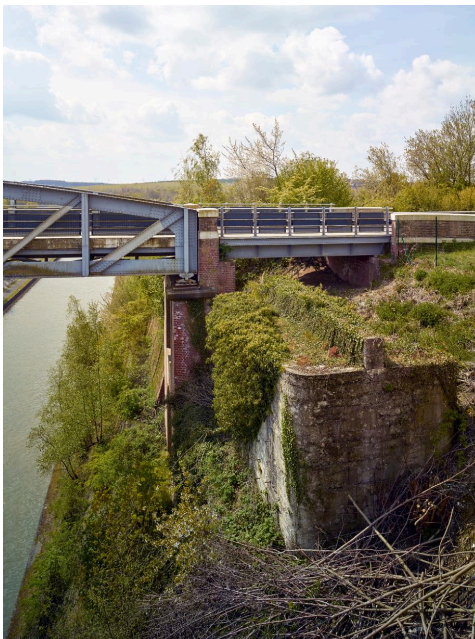
Pont sud (rive ouest). Vestige de la culée du pont provisoire britannique.
