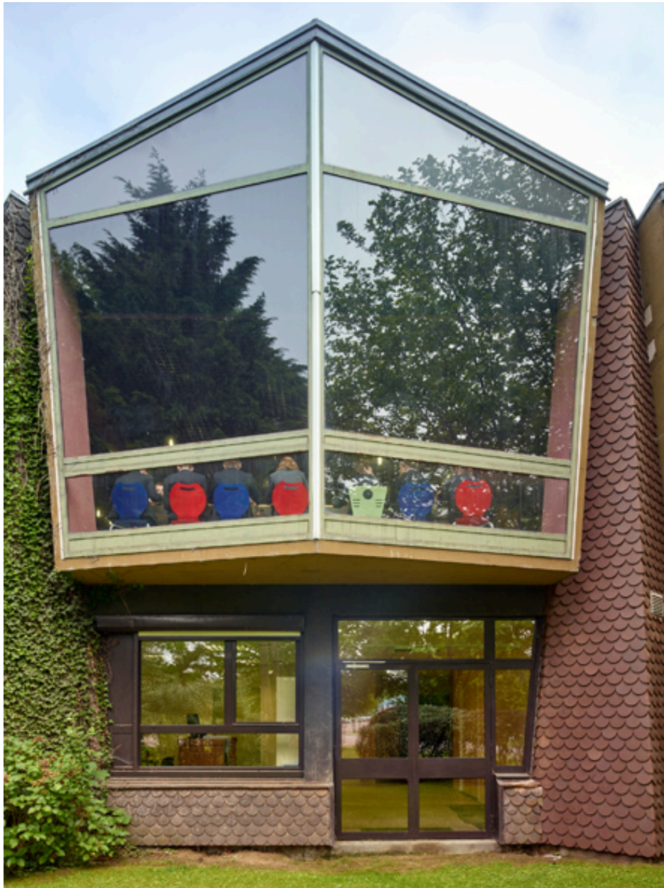
Vue rapprochée de face, d'un module préfabriqué de l'élévation de l'ancien restaurant d'application, côté nord.
