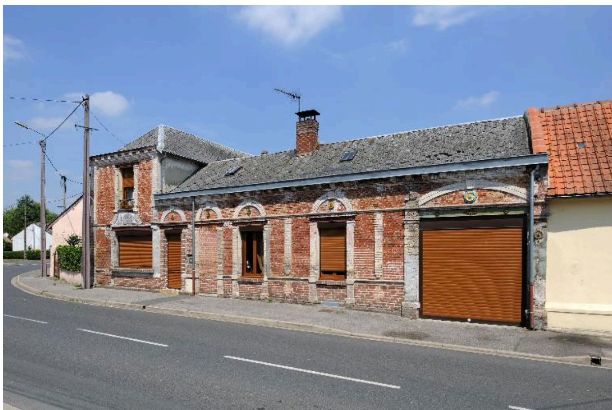
Vue d'ensemble sur rue.
