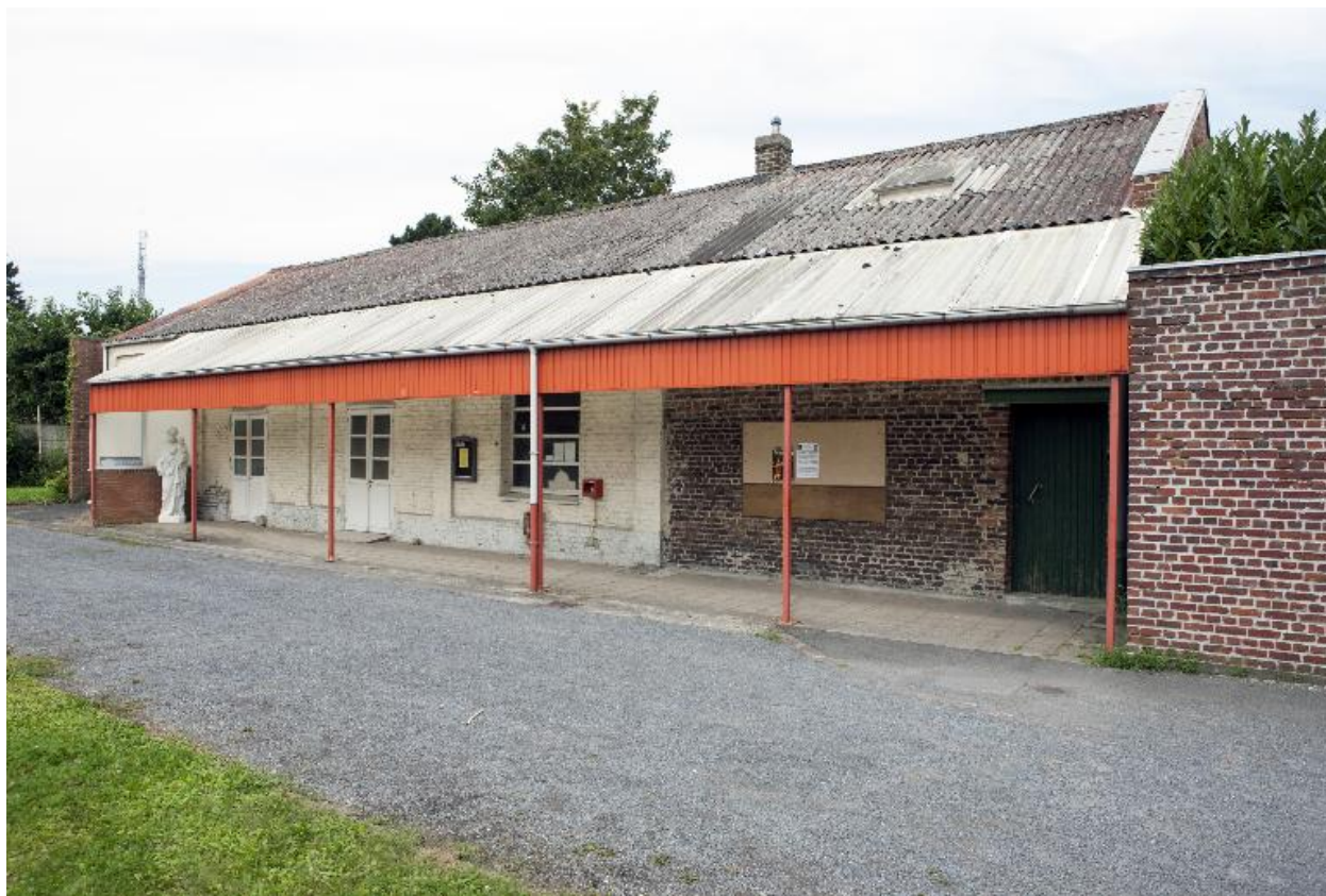
Élévation principale de la chapelle, vers l'ouest.
