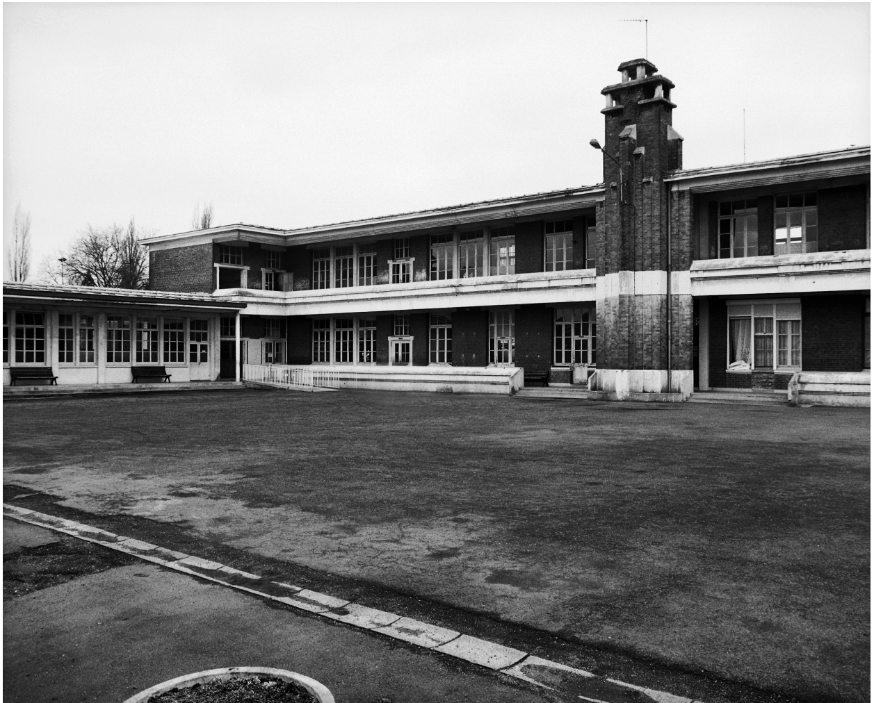
Elévation postérieure partielle.
