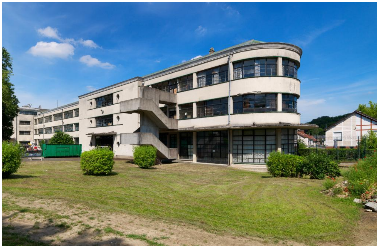
Vue générale depuis le sud-ouest.
