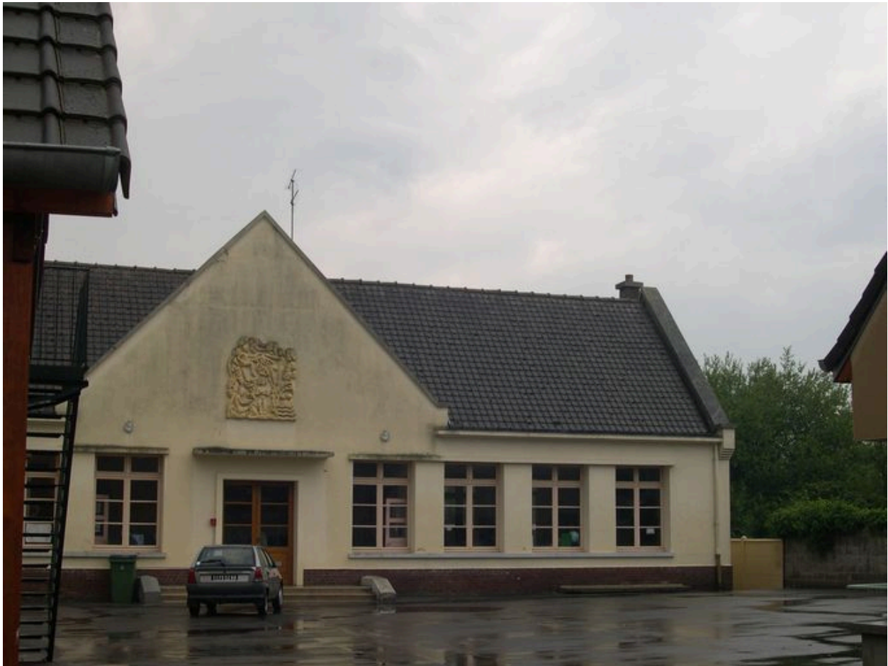
Détail sur la façade nord de l'école.
