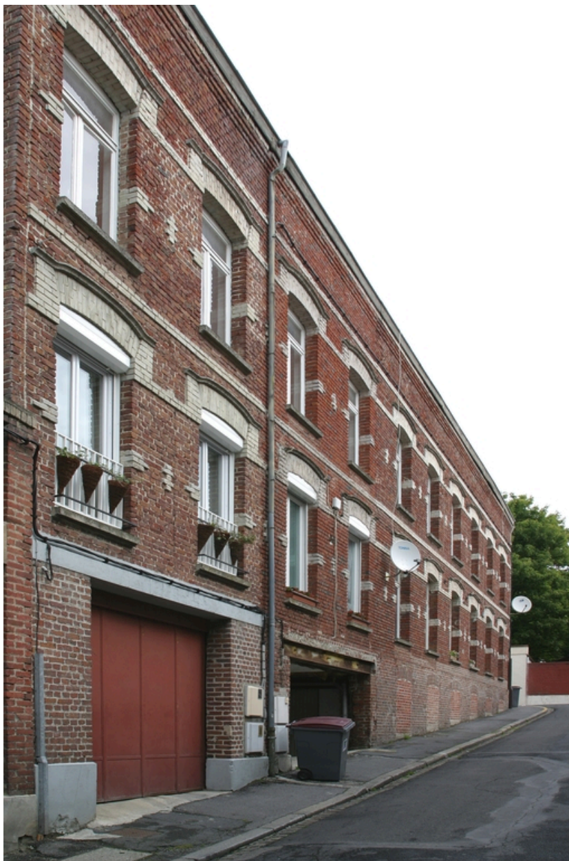
Façade antérieure des ateliers, rue de l'Amicale.
