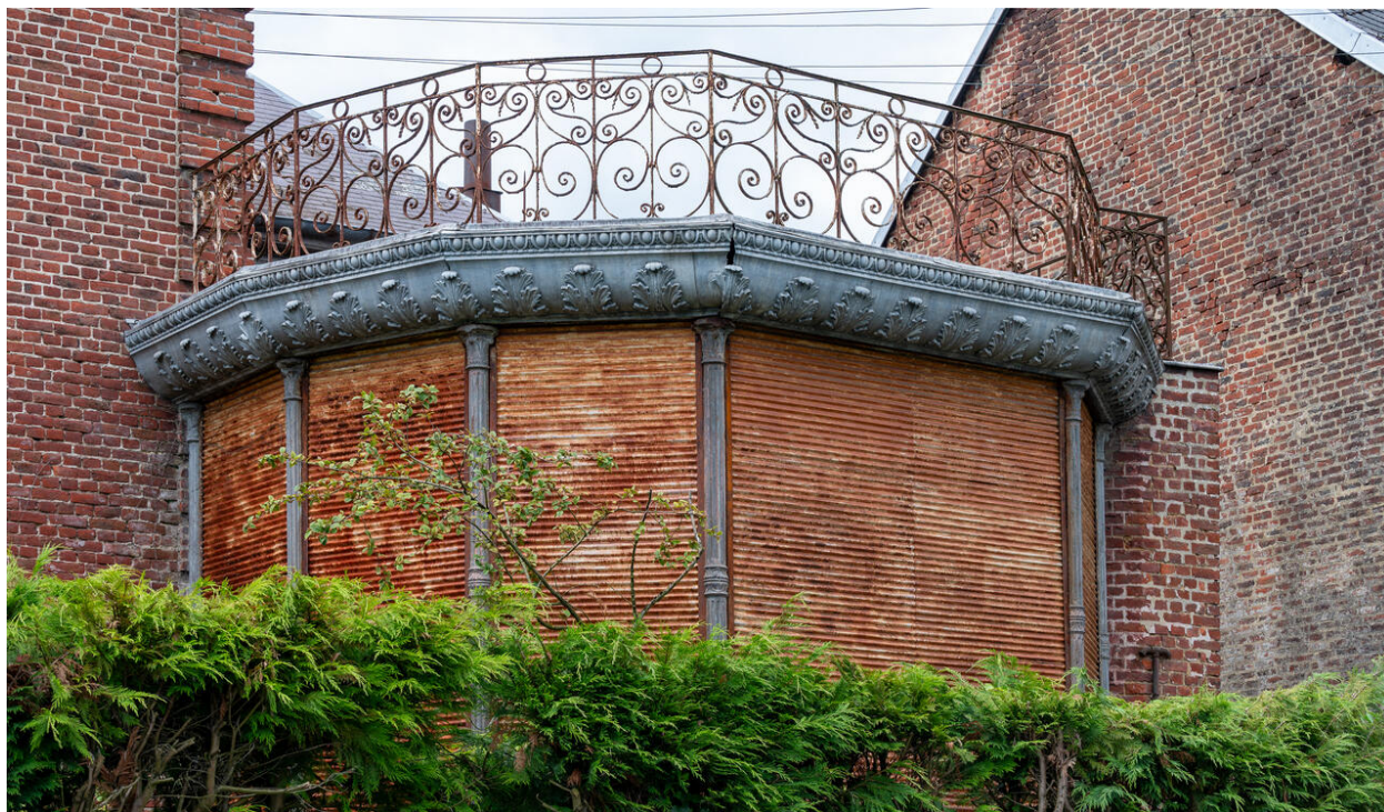
Détail de l'extension polygonale en zinc formant terrasse.
