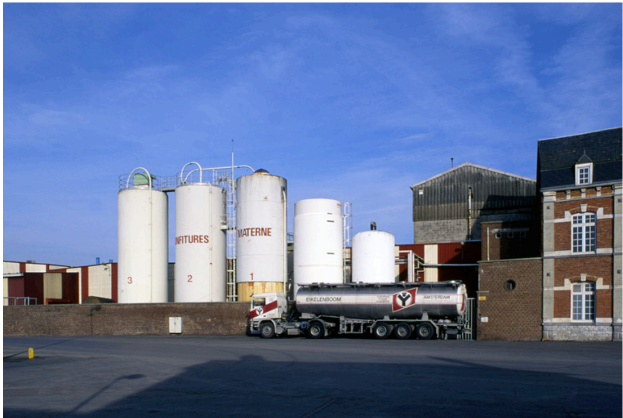
Vue des silos à sucre, édifés au sud de l'usine.
