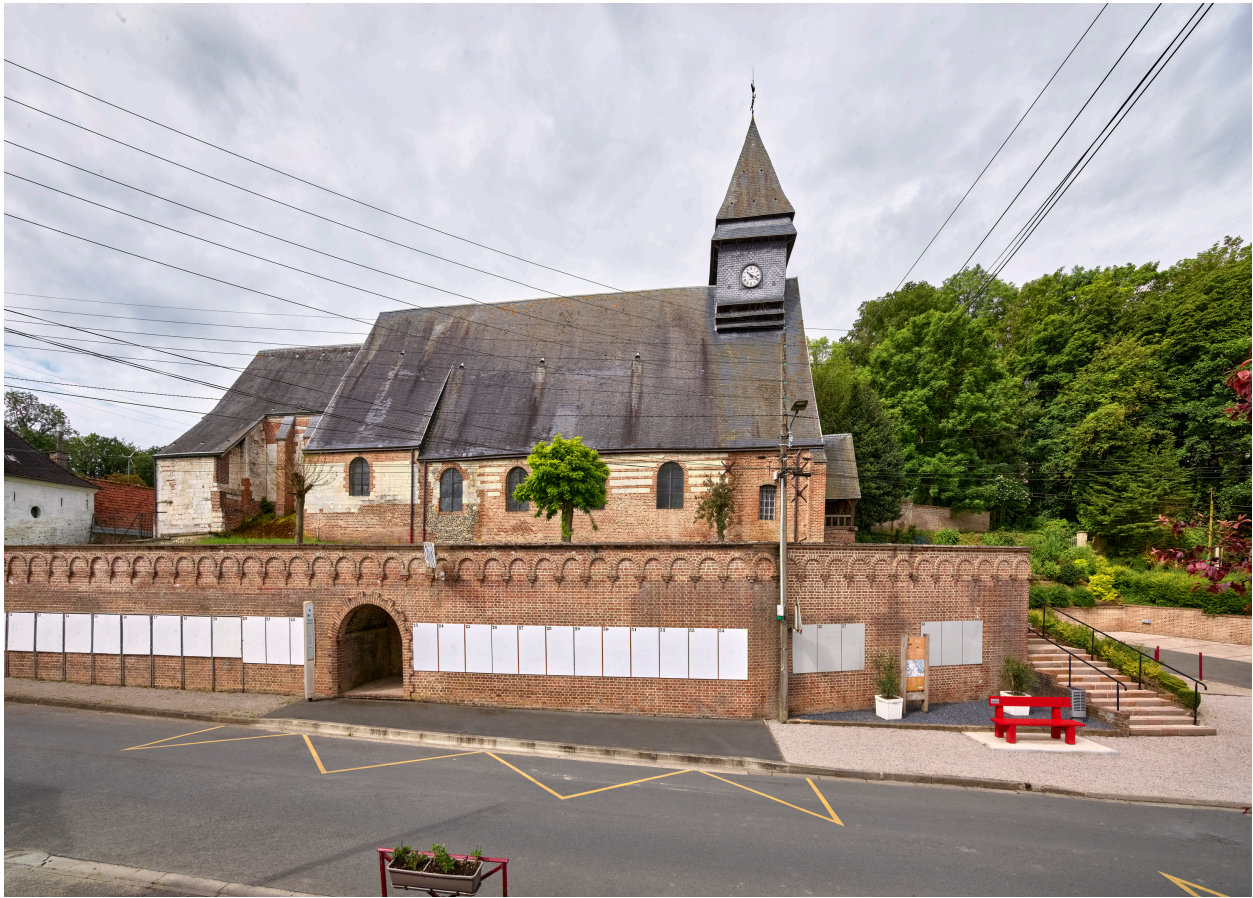
Vue d'ensemble de l'église, depuis l'est.
