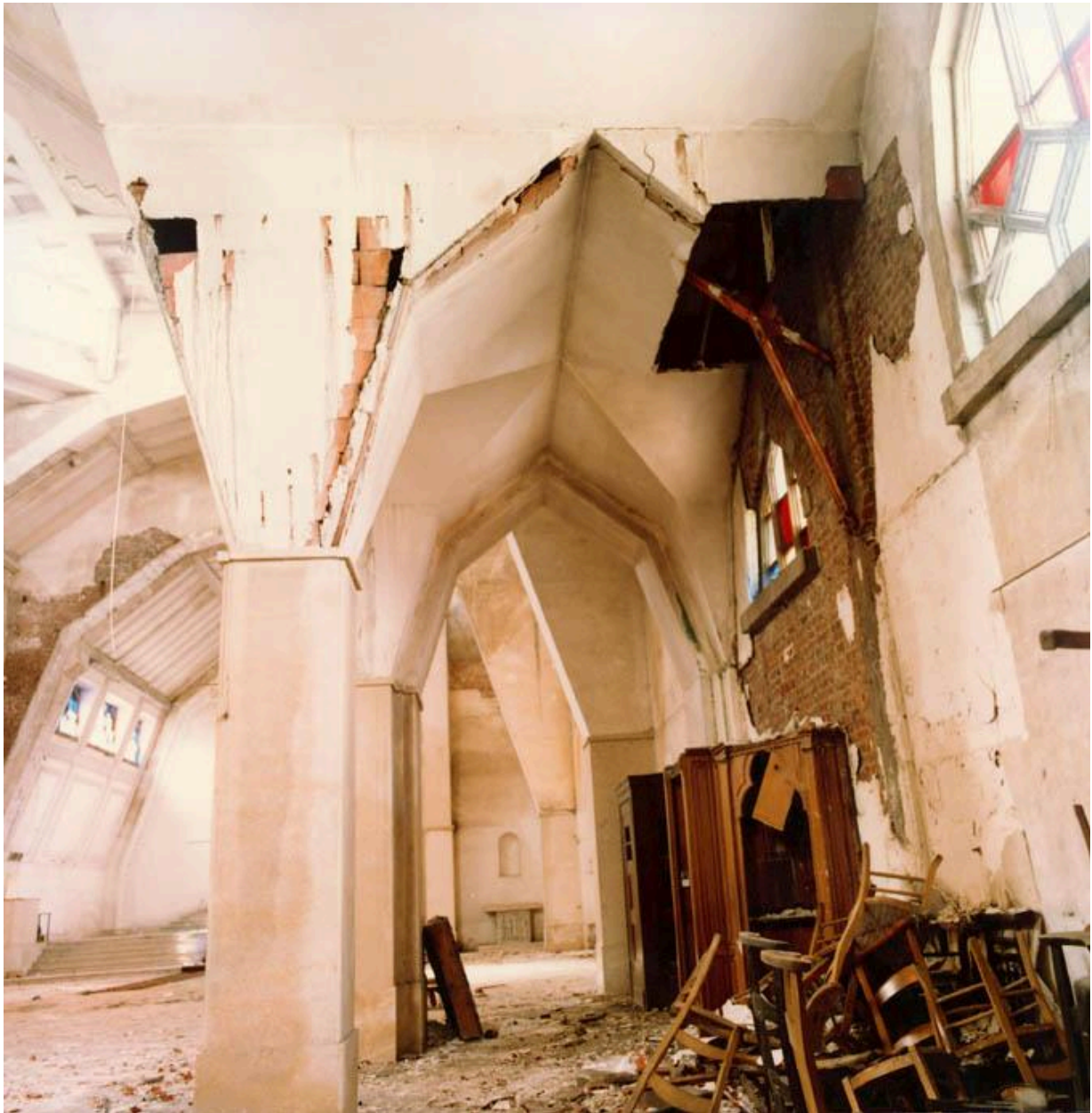
Vue intérieure, le bas côté occidental, avant sa destruction. Photographie, photographe inconnu, circa 1985-1986 (AC Aulnoye-Aymeries).
