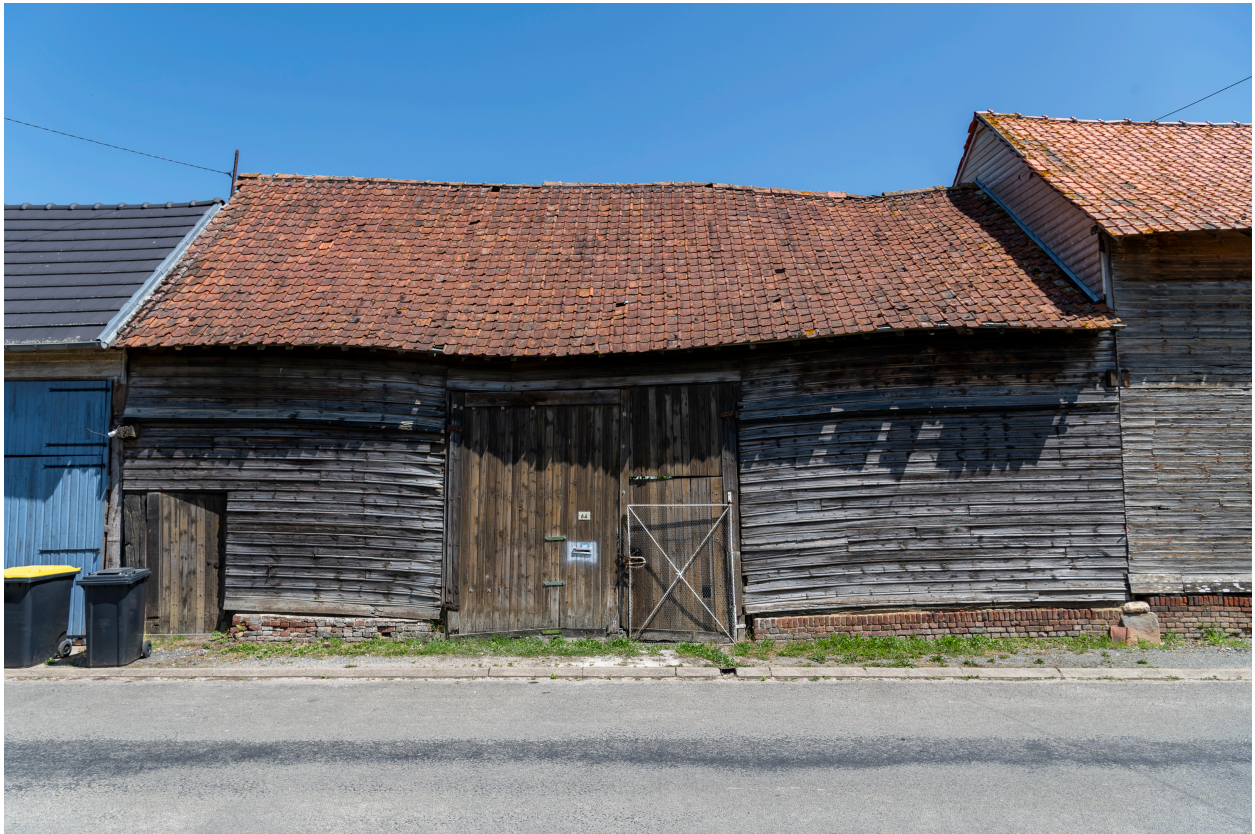
Grange sur rue avec entrée charretière, n°64 de la rue Marcel-Dassault, vue depuis le sud.
